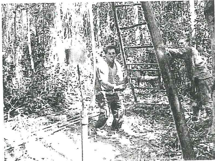
Sondagens de reconhecimento a percussão com ensaios de permeabilidade
